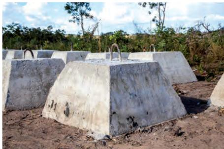
Figura 6. Estrutura de concreto para fixação dos tanques, poita.
