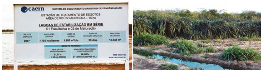
Figuras 6.139 e 6.140 – Imagens da estação de tratamento de esgotos da cidade de Pendências, RN (esq.), cuja água residuária é aproveitada para o cultivo agrícola de capim-elefante em área adjacente (dir.).
