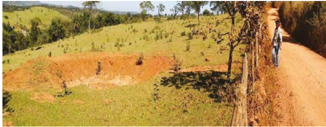
Figura 6.91 – Bacia de retenção em área de pastagem para captar a água da enxurrada desviada da estrada.
