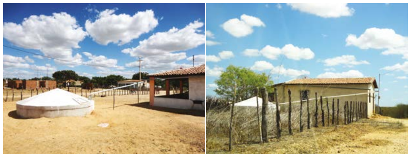
Figuras 6.141 e 6.142 – Imagens da tecnologia de captação de água da chuva pelo telhado e armazenamento em cisternas de alvenaria.
