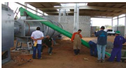
Figura 11.2 – Instalação das máquinas da fábrica-escola. Dezembro de 2012.
