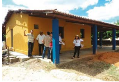
Figura 11.3 – Sede administrativa da fábrica-escola.
