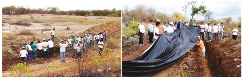
Figuras 6.123 e 6.124 – Construção da BS com abertura da valeta cortando o leito do rio temporário (esq.); aplicação da lona plástica barradora do fluxo subsuperficial (dir.).
