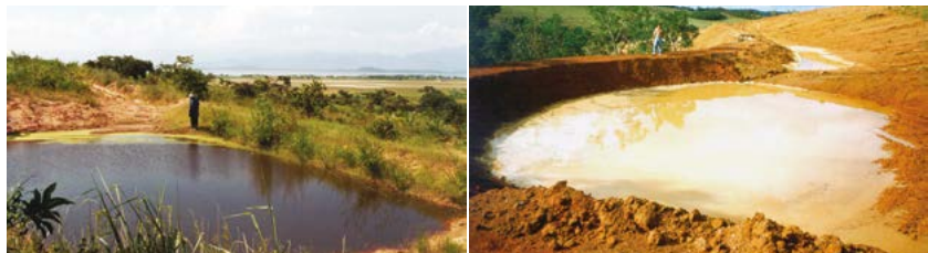
Figuras 6.77 e 6.78 – Bacias de retenção da água da chuva que escorre pelo terreno ou são conduzidas pelos terraços.
