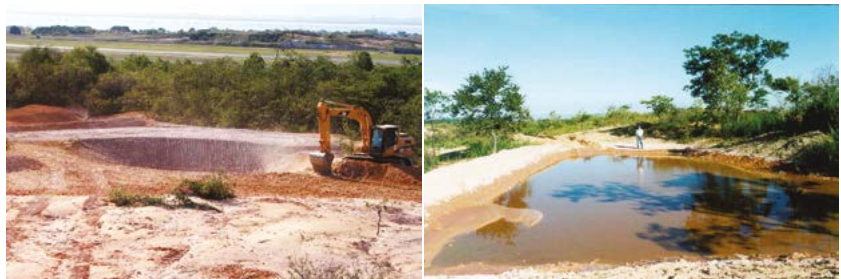
Figuras 6.106 e 6.107 – Bacias de retenção para armazenamento da água da chuva que escorre pelo terraço.
