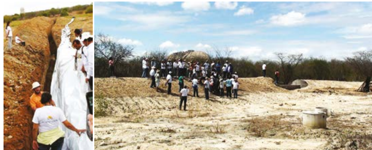
Figuras 6.125 e 6.126 – Aplicação da lona plástica barradora do fluxo subsuperficial (esq.); construção da cacimba e da BS com o sangradouro ao centro (dir.).
