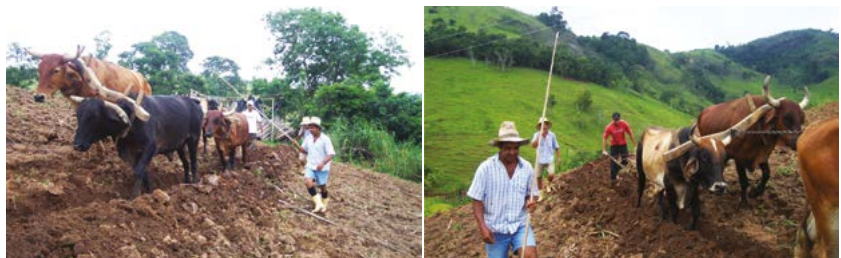
Figuras 6.59 e 6.60 – Detalhes do preparo de solo (esq.) e construção de terraço em curva de nível utilizando tração animal – junta de bois (dir.).
