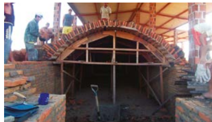
Figura 8.6 – Forno Hoffmann em construção em cerâmica na cidade de Tangará/RN na Grande Natal.
