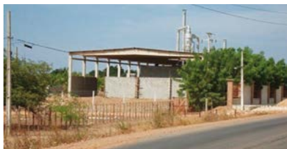
Figura 11.1 – Fábrica-escola de briquetes em construção no Campus Ipanguaçu do IFRN, dezembro de 2012.
