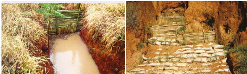
Figuras 6.81 e 6.82 – Paliçadas de bambu em voçorocas retendo a enxurrada (esq.) e de saco de terra associado com bambu em início de revegetação (dir.).
