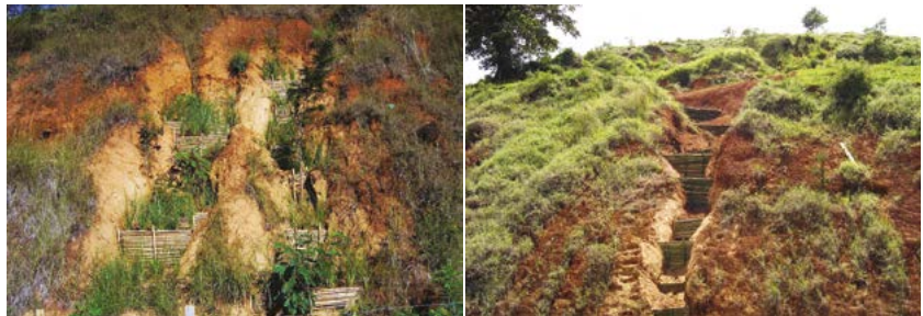
Figuras 6.111 e 6.112 – Paliçadas no interior de voçoroca para reduzir a velocidade da enxurrada e reter sedimentos.
