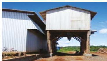
Figura 10.23 – Silo externo superior com abertura no chão, para abastecer os caminhões estacionados embaixo.
