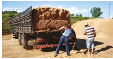
Figura 10.11 – Os resíduos são separados no pátio conforme o tipo.
