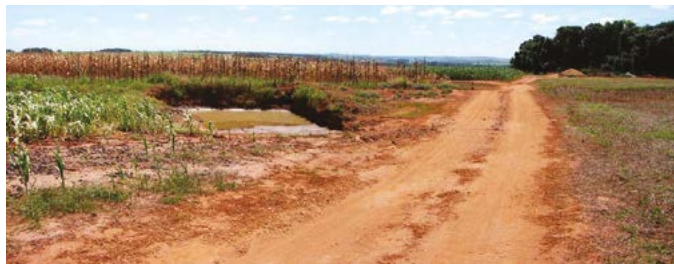
Figura 6.92 – Bacia de retenção em área de lavoura para captar a água da enxurrada desviada da estrada e conduzida pelo terraço.
