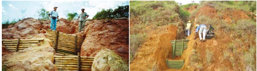
Figuras 6.83 e 6.84 – Paliçadas de bambu em encostas íngremes que apresentam voçorocas.
