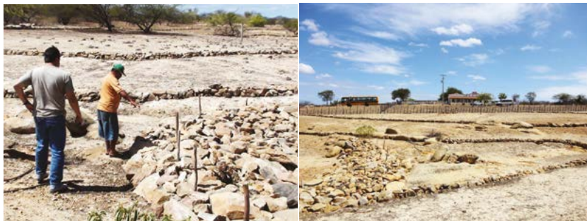
Figuras 6.120 e 6.121 – Detalhes dos cordões/renques de pedra em nível associados ao barramento assoreador.
