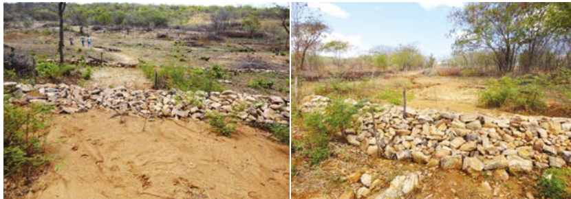
Figuras 6.118 e 6.119 – Detalhes da retenção de sedimentos por um barramento assoreador, em um local de concentração de enxurrada no Rio Grande do Norte.
