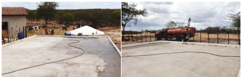
Figuras 6.143 e 6.144 – Imagens da tecnologia de captação de água da chuva por terreiro cimentado e armazenamento em cisternas de alvenaria. À direita, detalhe de fornecimento emergencial de água por caminhão-pipa.
