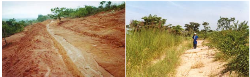
Figuras 6.104 e 6.105 – Detalhe de terraço recém-construído (esq.) e vegetado com capim-vetiver (dir.).
