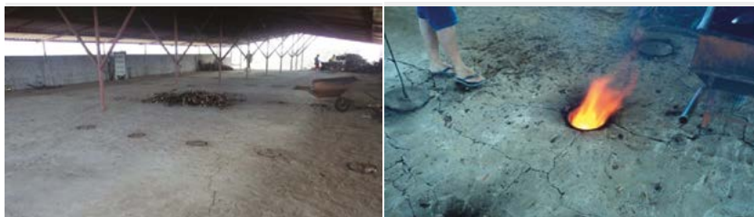
Figuras 7.23 e 7.24 – Parte superior de um forno Hoffman com as aberturas para alimentação do fogo, Assú, RN.
