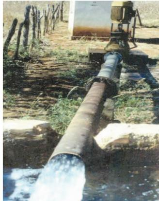
de captação da água de irrigação, atacados pela constante corrosão devido ao elevado teor de enxofre/sulfatos na água de irrigação.
