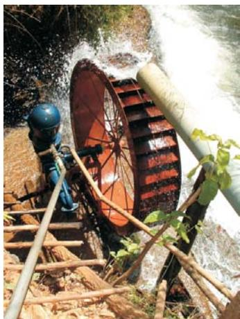
**Figura 9.** Captação de água da Agrovila Mambai, composta com bomba e roda d'água.
